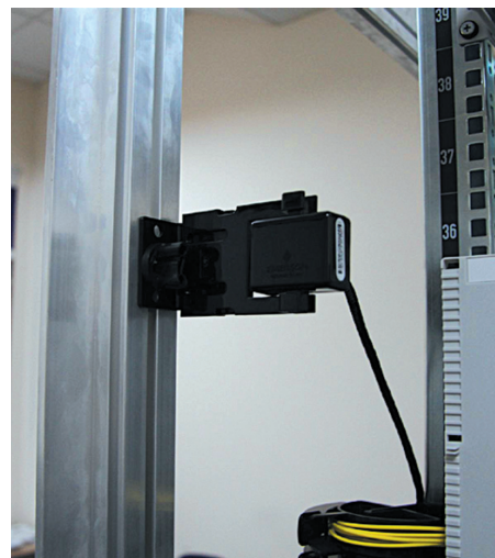
Датчики легко устанавливаются внутри шкафа Knurr DCM, не отнимая полезного пространства
