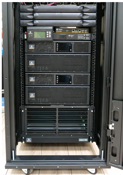
Рис. Принципиальная схема и внешний вид конструкции микро-ЦОД «Альфа Гриссин»
